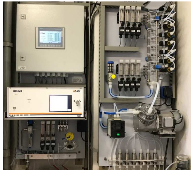
图 5: GC-IMS集成到Bilfinger公司现场的过程测量和控制技术系统中。
