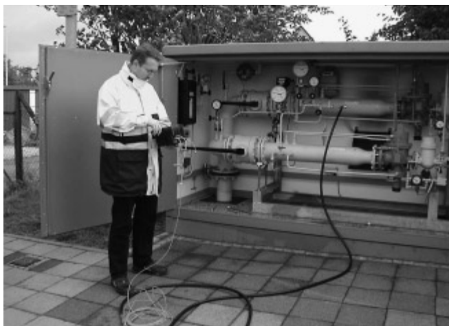
Bild 7. Messung an einer Mess- und Regelstation vor Ort.
